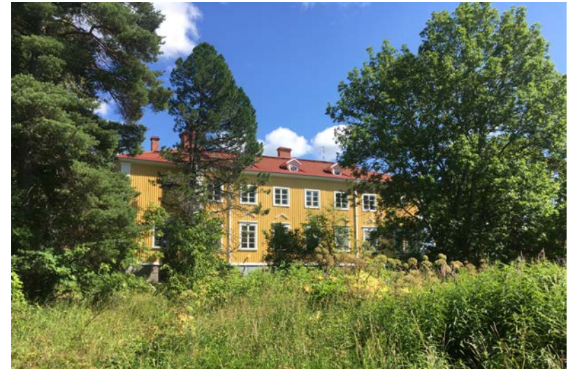
Kuva 43. Pappilan päärakennus kuvattuna puutarhan takaa. Julkisivun kunnostus on kuvassa kesken
